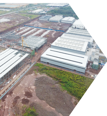
建设中的天钧项目
