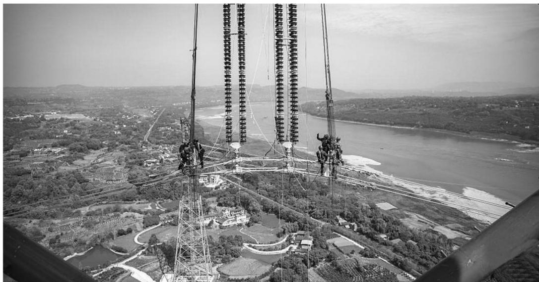
近日,历经13天连续施工,“西电东送”大动脉白鹤滩-浙江±800千伏特高压直流输电工程(白浙线)重庆段顺利完成长江大跨越放线作业。白浙线是国家“西电东送”、清洁能源外送的重大电网工程,途经四川、重庆、湖北、安徽、浙江5省市,线路长度2140公里。其中,重庆段线路长度331.25公里,于2021年10月启动建设,计划于9月底实现全线贯通,11月具备带电条件。图为工人在白鹤滩-浙江±800千伏特高压直流输电线路工程(重庆段)江津长江大跨越施工现场作业。
