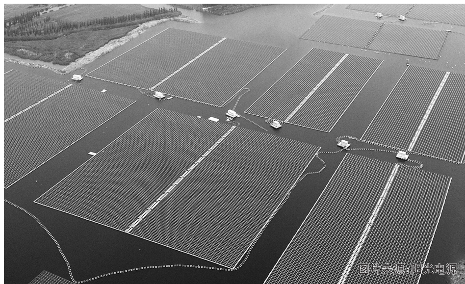
山东济宁微山领跑基地31MW漂浮电站
