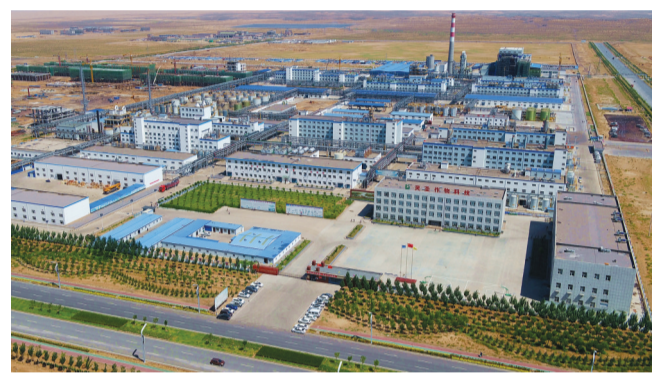
建设中的阿拉善高新区巴音包工业园区
