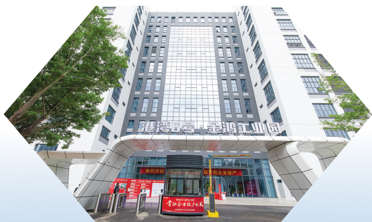
珠海高新区首个“工业上楼”示范产业园区——港湾6号·金鸿工业园二期
