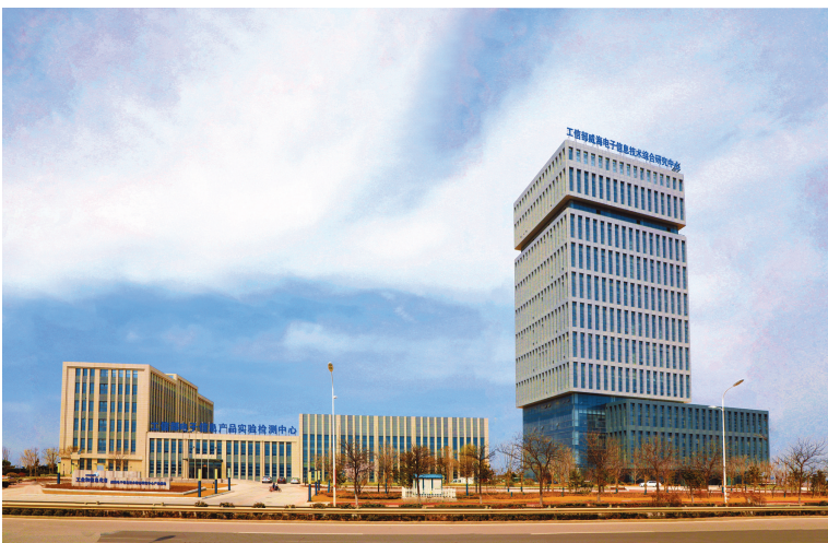
工信部威海电子信息综合研究中心
