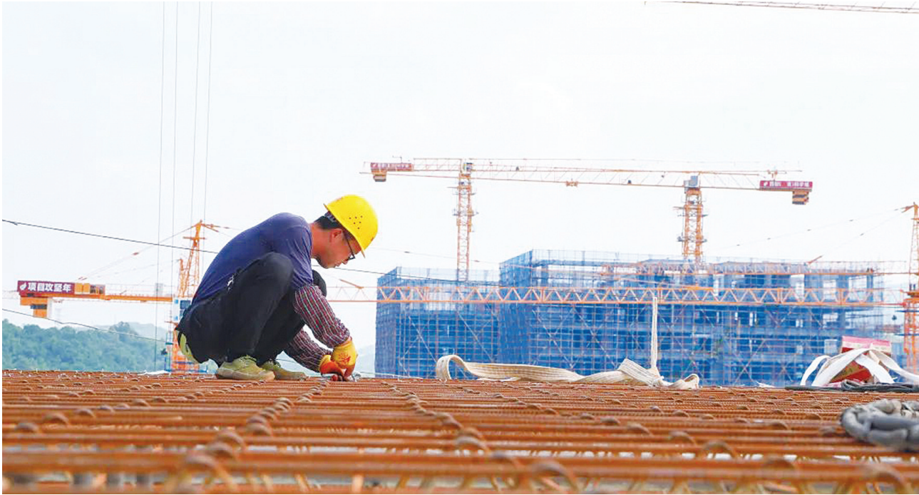
工人正在马不停蹄捆扎钢筋。
