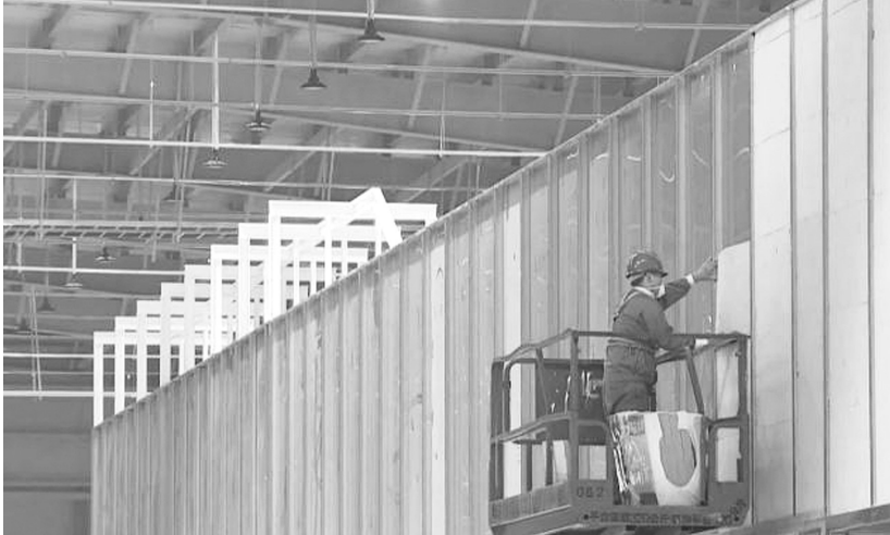
山东新北洋信息技术股份有限公司建设施工现场
