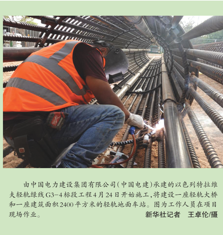
由中国电力建设集团有限公司(中国电建)承建的以色列特拉维夫轻轨绿线G3-4标段工程4月24日开始施工,将建设一座轻轨大桥和一座建筑面积2400平方米的轻轨地面车站。图为工作人员在项目现场作业。
