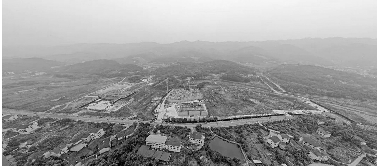
西部(重庆)科学城中科院重庆科学中心一期项目建设现场
