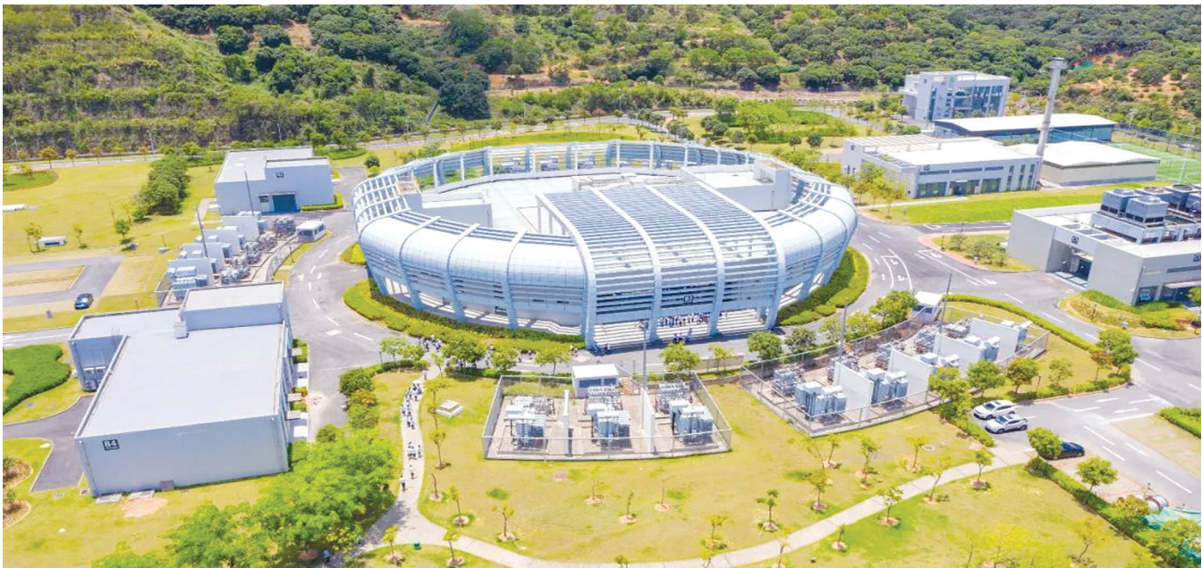
中国散裂中子源大科学装置
