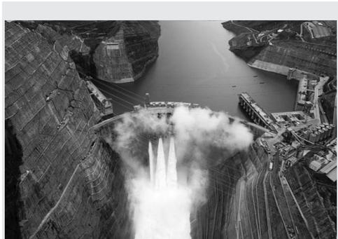
近日,白鹤滩水电站水垫塘完成首次排干检查,正式恢复泄洪消能作用。水垫塘是大坝工程重要的泄洪消能设施,对大坝坝后河床基础稳定起着关键性作用。白鹤滩水电站位于云南省巧家县和四川省宁南县交界处的金沙江干流之上,总装机容量1600万千瓦。
