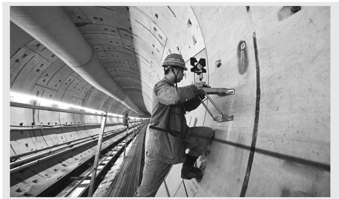
近日,在天津地铁11号线苑北路站至海河东路站盾构区间施工现场,建设者在做好疫情防控工作的同时积极推进项目建设,确保工程建设进度。图为4月5日,工作人员进行测量作业。
