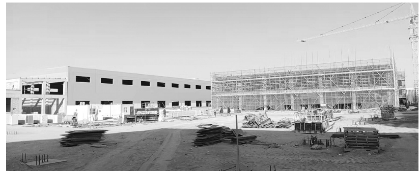
大地熊施工现场
