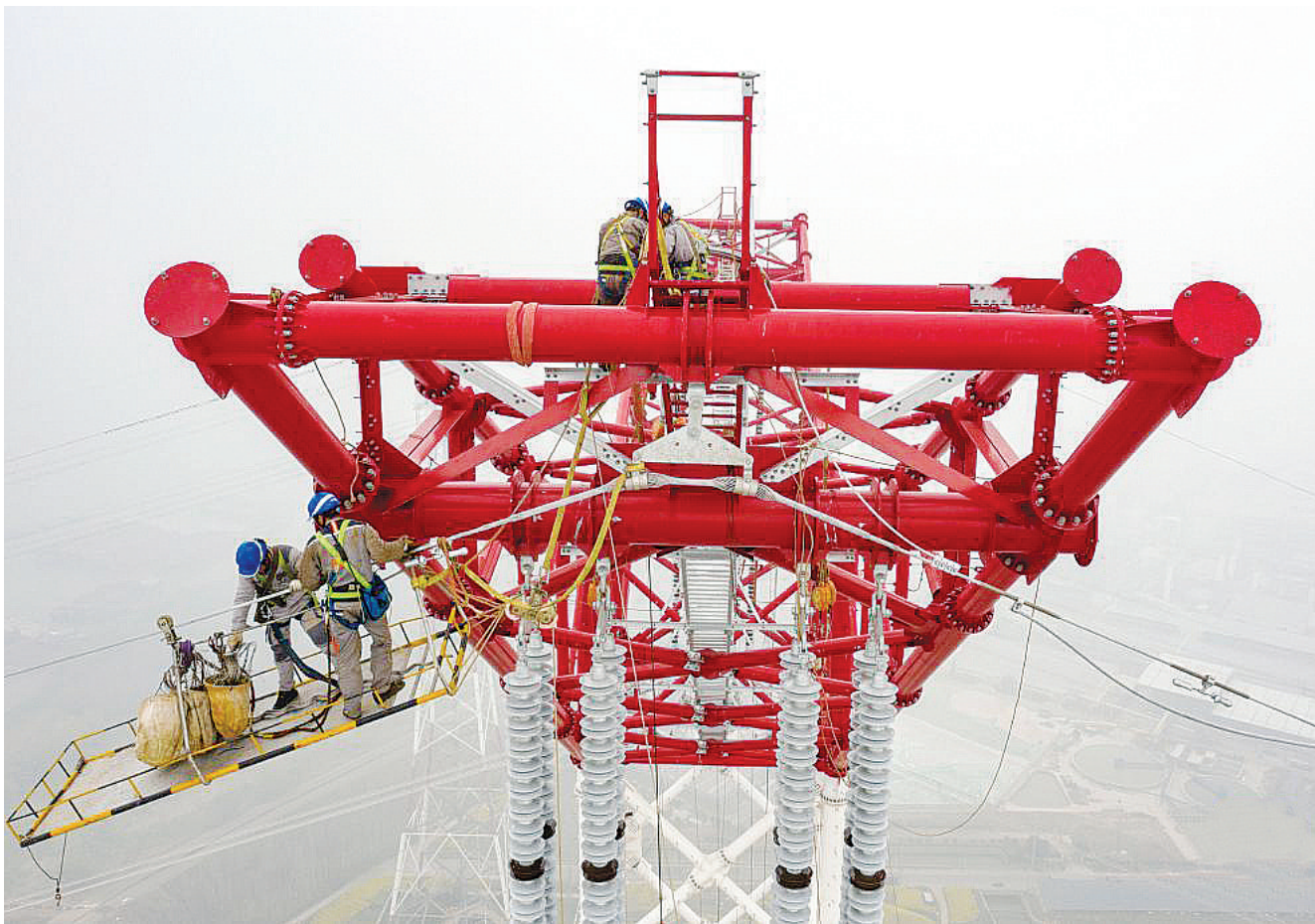
近日,白鹤滩—江苏±800千伏特高压直流输电工程安徽段跨越长江放线工程完成最后6根导线的展放,标志着特高压“白江线”安徽段长江大跨越线路贯通。白鹤滩—江苏±800千伏特高压直流输电工程是我国“西电东送”战略的重点工程,是促进国家能源结构调整和节能减排的清洁能源项目。工程投运后,每年输送电力将超过312亿千瓦时。图为在安徽芜湖的长江边,安徽送变电工程有限公司施工人员在高空进行特高压输电线路跨江作业。
