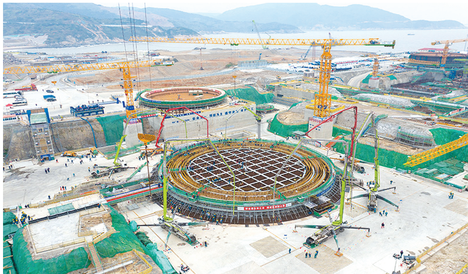
近日,浙江三澳核电项目2号机组核岛浇筑第一罐混凝土,标志着该机组主体工程正式开工。据悉,三澳核电项目是民营资本参股的核电项目,规划建设6台我国自主三代核电技术“华龙一号”机组,1号机组主体工程已于2020年12月31日开工,项目6台机组全部商运后,年发电量将达到525亿千瓦时,每年可减少标煤消耗1604万吨,减少二氧化碳排放4336万吨,相当于造林11.8万公顷。
