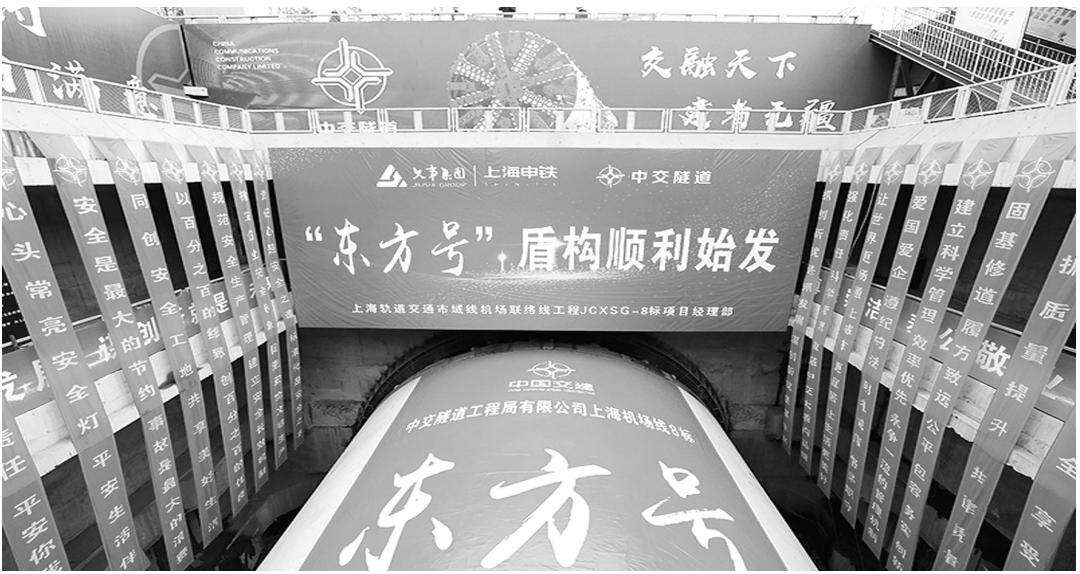
2021年12月28日,在上海机场联络线8标项目工地,由中国交建自主研发的“东方号”超大直径盾构机安装调试完毕开始掘进作业。“东方号”盾构机将用于上海机场联络线张江站至度假区站区间掘进施工,隧道内部结构采用全预制拼装,掘进距离5.69公里,是上海机场联络线工程浦东段最长区间隧道。图为“东方号”超大直径盾构机始发现场。
