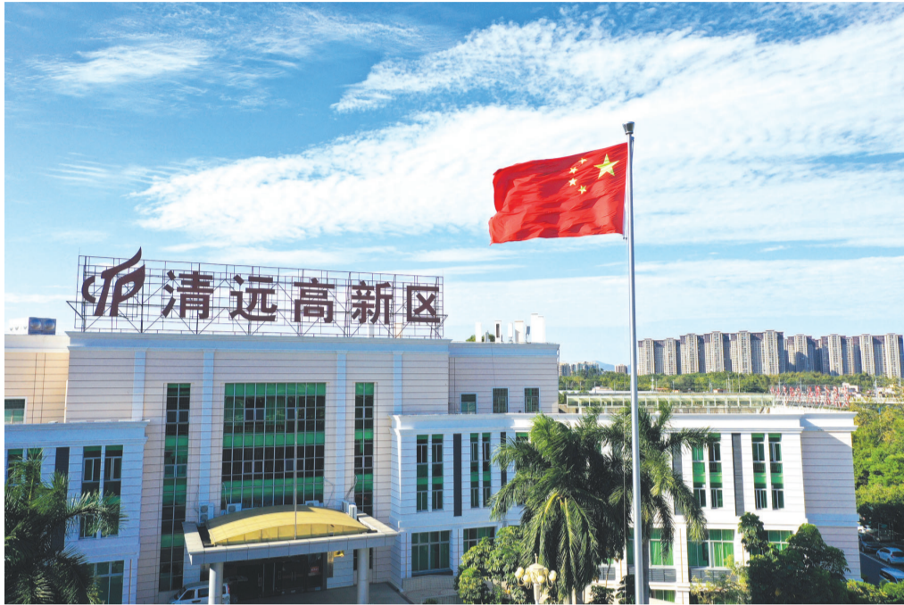
清远高新区办公大楼
