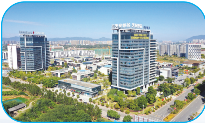
清远高新区百嘉工业园内天安智谷大楼
