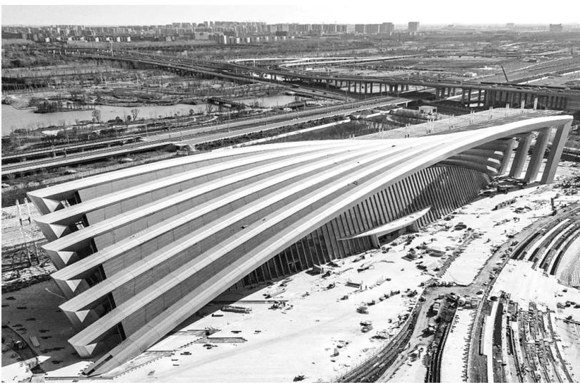
11月30日,江苏盐城黄海湿地博物馆项目金属屋面工程完工。据项目施工方介绍,盐城黄海湿地博物馆项目毗邻盐城湿地公园,是国内比较少见的由火车站旧址改造建成的博物馆,屋面采用七福钢管桁架结构,改造后将成为当地集展览、科普、研学为一体的现代化新型湿地博物馆。图为江苏盐城黄海湿地博物馆(无人机照片)。
