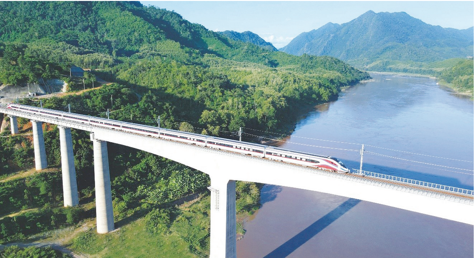
12月3日,连接中国昆明和老挝万象、全线采用中国标准的中老铁路全线开通运营,自此老挝迈入铁路运输时代。作为“一带一路”、中老友谊标志性工程的中老铁路,将为加快建成中老经济走廊、构建中老命运共同体提供有力支撑。图为“澜沧号”动车组驶过琅勃拉邦湄公河特大桥。 国铁集团供图
