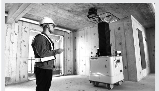
佛山顺德风桐花园是住房和城乡建设部智能建造试点项目之一。走进风桐花园这块“试验田”,测量机器人、混凝土天花板打磨机器人、混凝土内墙面打磨机器人……在施工人员的操控下开展常态化工作。据介绍,建筑机器人的进驻可以让施工效率得到2到3倍提升。图为施工人员操控混凝土天花板打磨机器人对天花板进行打磨。
