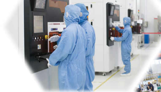
沈阳芯源公司净化车间
