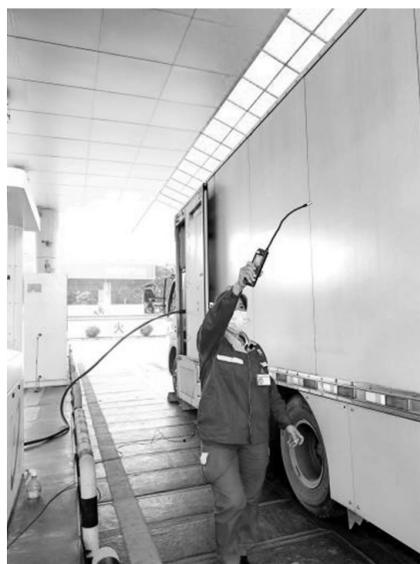
气站工作人员用氢气检测仪检查车辆
