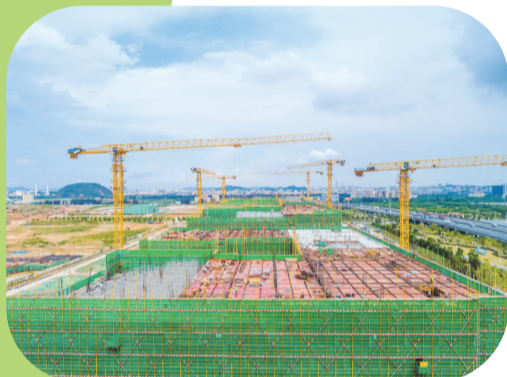
OPPO智能制造中心建设现场
