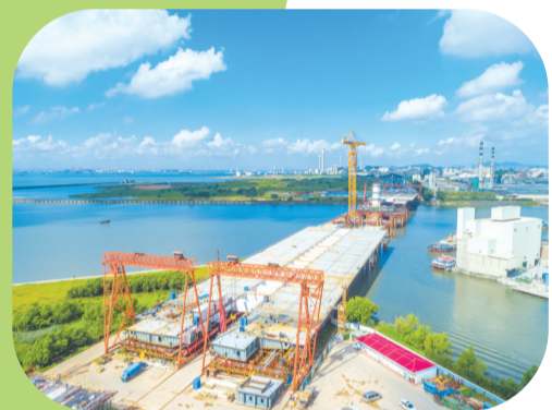
滨海湾大桥建设现场
