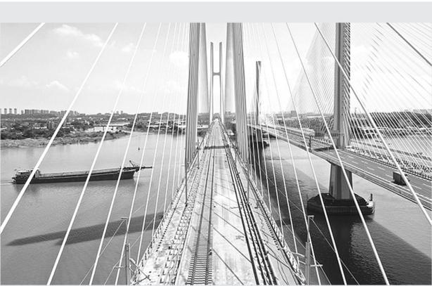
近日,由中铁十一局承建的粤港澳大湾区基础设施“硬联通”重点工程——广州南沙港铁路跨西江特大斜拉桥完成桥面左线铺轨施工,为工程如期建成开通奠定基础。该桥位于广东省佛山市和江门市交界处,全长1117.5米。图为完成左线铺轨的广州南沙港铁路跨西江特大斜拉桥(无人机照片)。
