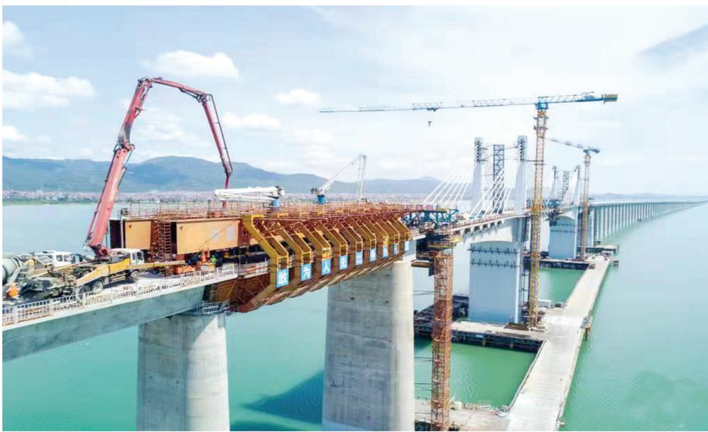
近日,由中铁十一局承建的新建福厦铁路湄洲湾跨海大桥最后一孔移动模架现浇梁结束浇筑,完成首次海上高铁架梁任务。下一步,该模架将整体后移,在海岸上进行拆解,运输至下一工程项目,继续发挥作用。这个被称为“高空移动的桥梁预制工厂”的高铁移动模架,可行进在已完成的桥墩进行高铁箱梁现场浇筑施工,最大承载重量达1200吨,可抵御14级台风,解决了“千吨级”40米箱梁海域现浇施工难题,是我国目前最大跨度的高铁移动模架。图为大型机械在新建福厦铁路湄洲湾跨海大桥移动模架浇筑混凝土(无人机照片)。
