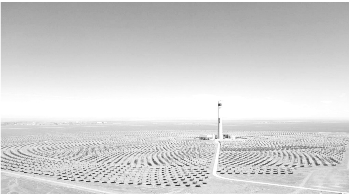
8月25日是全国低碳日。在新疆伊吾县淖毛湖镇的茫茫戈壁里,百米高塔巍然耸立,万余面定日镜“逐日”而动。作为新疆第一座光热发电站,哈密50兆瓦熔盐塔式光热发电站不仅污染物零排放,还通过储存热能实现24小时持续发电,为新疆绿色低碳发展指引方向。
