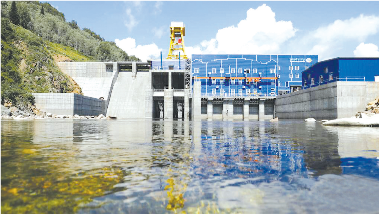
由中国长江三峡集团有限公司旗下的中国水利电力对外有限公司承建的哈萨克斯坦图尔古松水电站日前实现全部机组投产发电。据介绍,图尔古松水电站位于哈萨克斯坦东哈萨克斯坦州图尔古松河上,总装机容量24.9兆瓦。项目于2017年开工建设,是该流域梯级规划的第一座电站,也是共建“一带一路”框架下中哈产能合作水电领域首个落地的重点项目。图为哈萨克斯坦图尔古松水电站。
