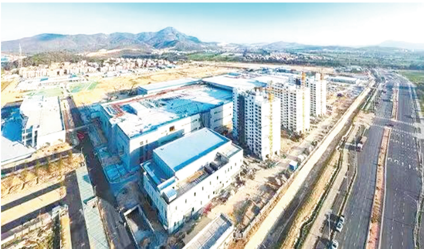
正在厦门火炬高新区建设的中航锂电项目。
