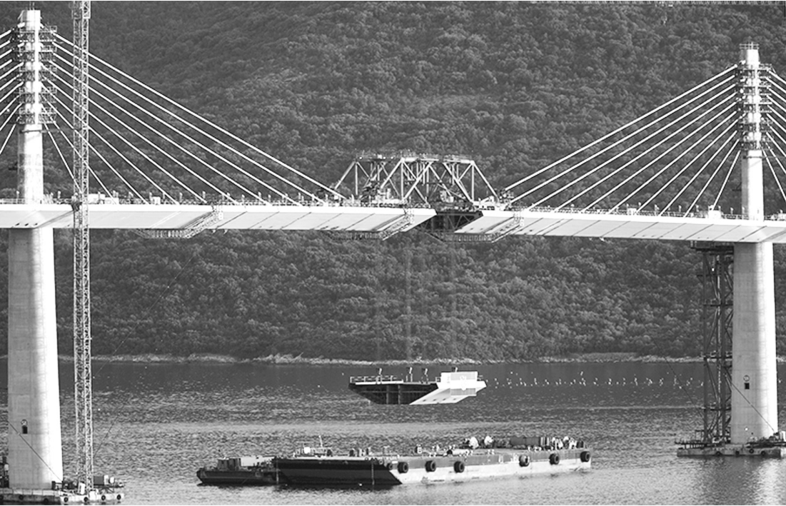
近日,随着中国建设者用桥面吊机把最后一片重达220吨的钢箱梁提升到位并完成焊接,中国企业承建 的克罗地亚佩列沙茨跨海大桥成功合龙。佩列沙茨大桥是一座长2440米、宽22.5米的公路斜拉桥,横跨克罗地亚南部亚得里亚海的小斯通湾,连接该国大陆与佩列沙茨半岛。图为佩列沙茨大桥的最后一片钢箱梁被缓缓吊起。
