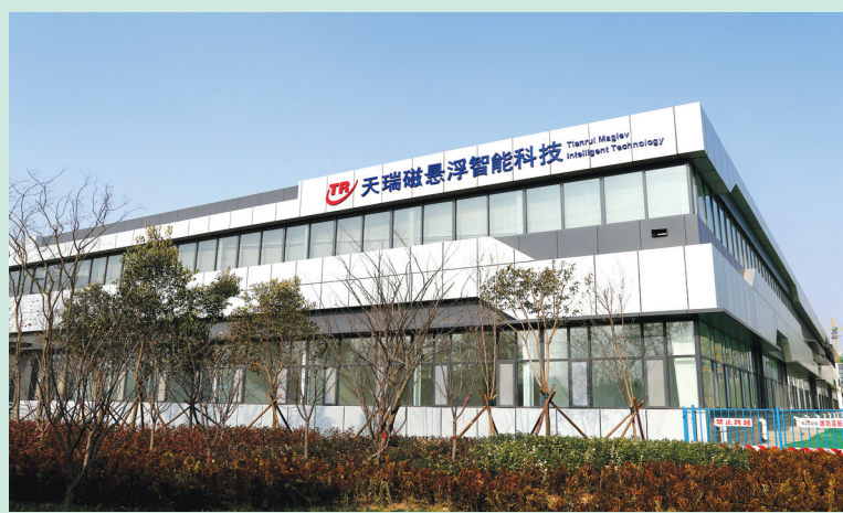
天瑞磁悬浮智能科技项目
