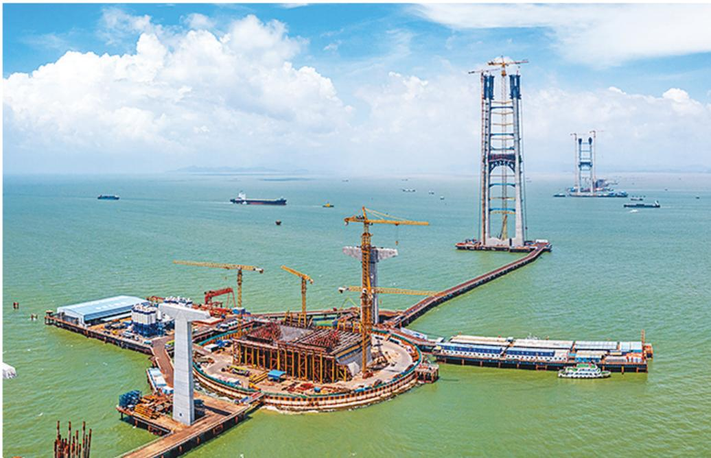
6月17日，随着第48节塔柱混凝土浇筑完成，由中交二航局承建的深中通道伶仃洋大桥东索塔完成封顶。深中通道项目采用东隧西桥方案，全长24公里，集“桥、岛、隧、地下互通”为一体，是粤港澳大湾区又一项超级跨海集群工程，建成后将成为联系珠江东西两岸的直连通道。图为深中通道伶仃洋大桥东索塔。
