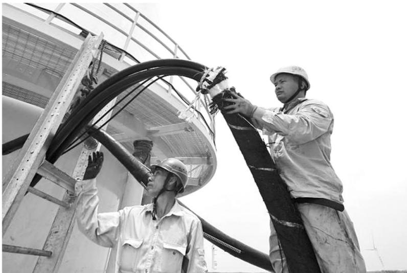
近日,“华电睿风”首台6.2兆瓦主控系统国产化风机在华电福清海坛海峡海上风电项目成功投运,这是国产风电主控系统在海上风电机组的首次应用,标志着我国海上风电机组实现了主控系统的自主可控。图为工程技术人员乘船登上上海上风电主控系统国产化机组,进行设备调试。
