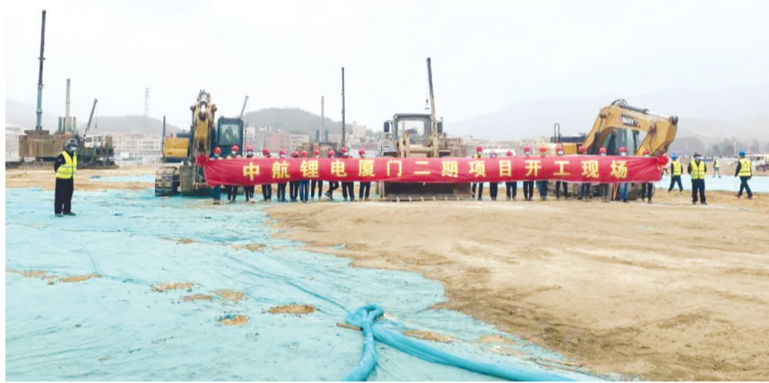
厦门火炬高新区中航锂电厦门二期项目开工。
