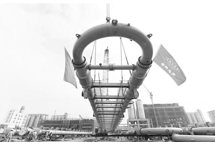
近日,年产120万吨共相聚丙烯项目环管反应器在福建福清的中景石化科技园首次吊装。该项目总投资40亿元,达产后年产值可达150亿元,投产后可改变我国共相聚丙烯大量依靠进口的局面。
