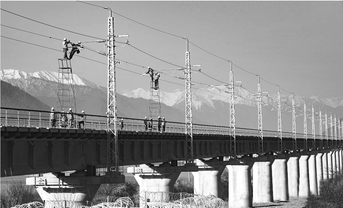
目前拉萨至林芝铁路新建的桥梁、隧道、路基铺架主体工作已全部完成，具备静态验收条件，4月1日起至4月30日，拉萨至林芝铁路进入静态验收阶段。拉林铁路是国家“十三五”规划重点工程项目，全长435公里，设计时速160公里，是西藏首条电气化铁路。图为3月30日中铁电气化局集团技术人员在拉林铁路进行接触网精调作业。
