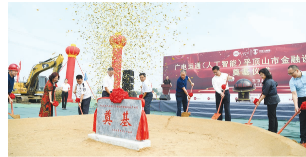
2020年7月15日,广电运通(人工智能)平顶山市金融设备产业园项目举行开工仪式。
