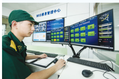
中银电池车间控制室
