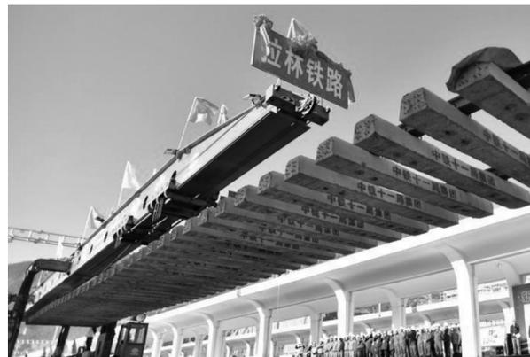
2020年12月31日,川藏铁路拉萨至林芝段铺轨完成。川藏铁路拉林段是西藏自治区首条电气化铁路,全长约435公里,设计时速160公里。
