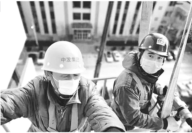
中发集团工人正在作业
