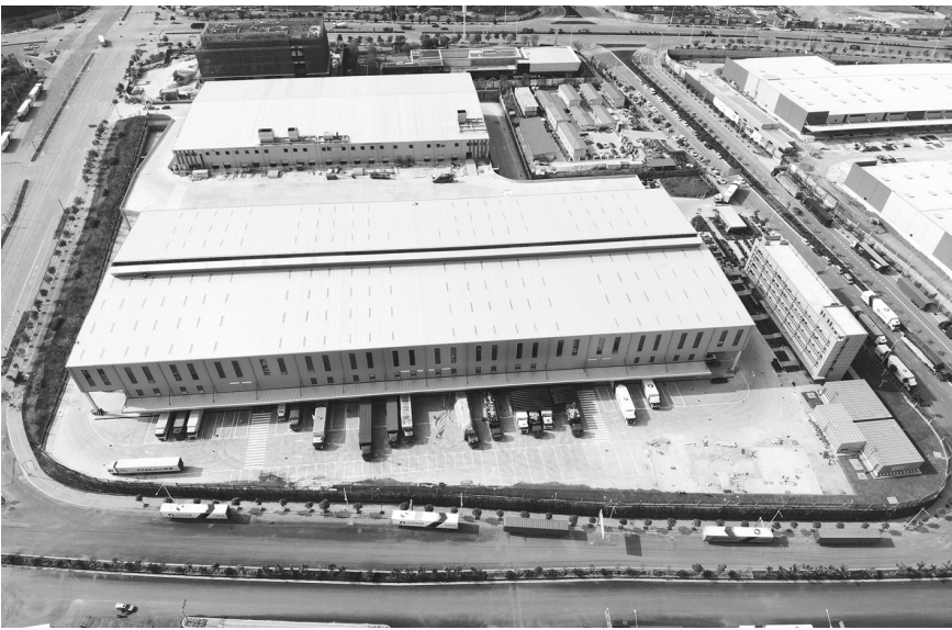
中新南宁国际物流园中新智慧园通过竣工验收
