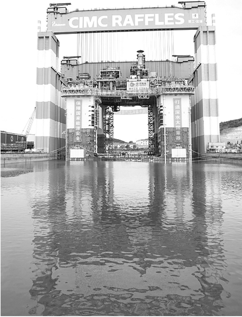
10月29日,我国自主建造的半潜式储油平台主体工程顺利完成,这也是全球首个万吨级半潜式储油平台。该储油平台最大储油量近2万立方米,将用于我国首个1500米深水自营大气田——陵水17-2项目,预计明年1月竣工交付。据了解,该储油平台搭载近200套关键油气处理设备,总高度达90.5米,总重量达5.3万吨,最大排水量超过10万吨。它的建成标志着我国深水油气田开发能力和深水海洋工程装备建造水平迈上了新台阶。
