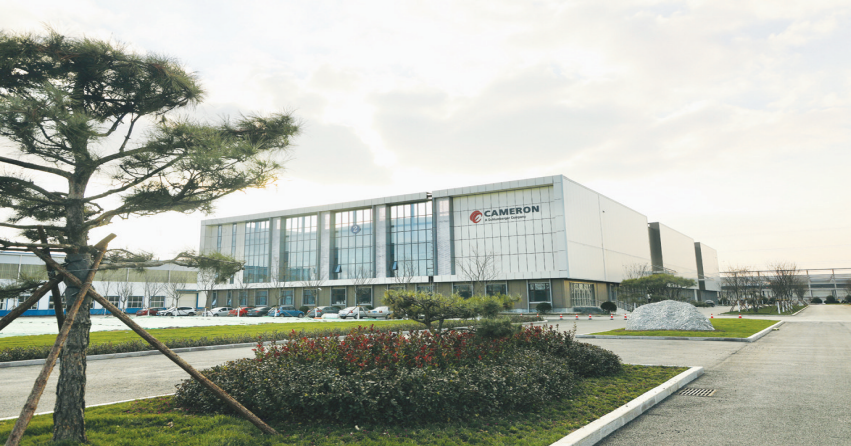
潍坊航空航天产业园
