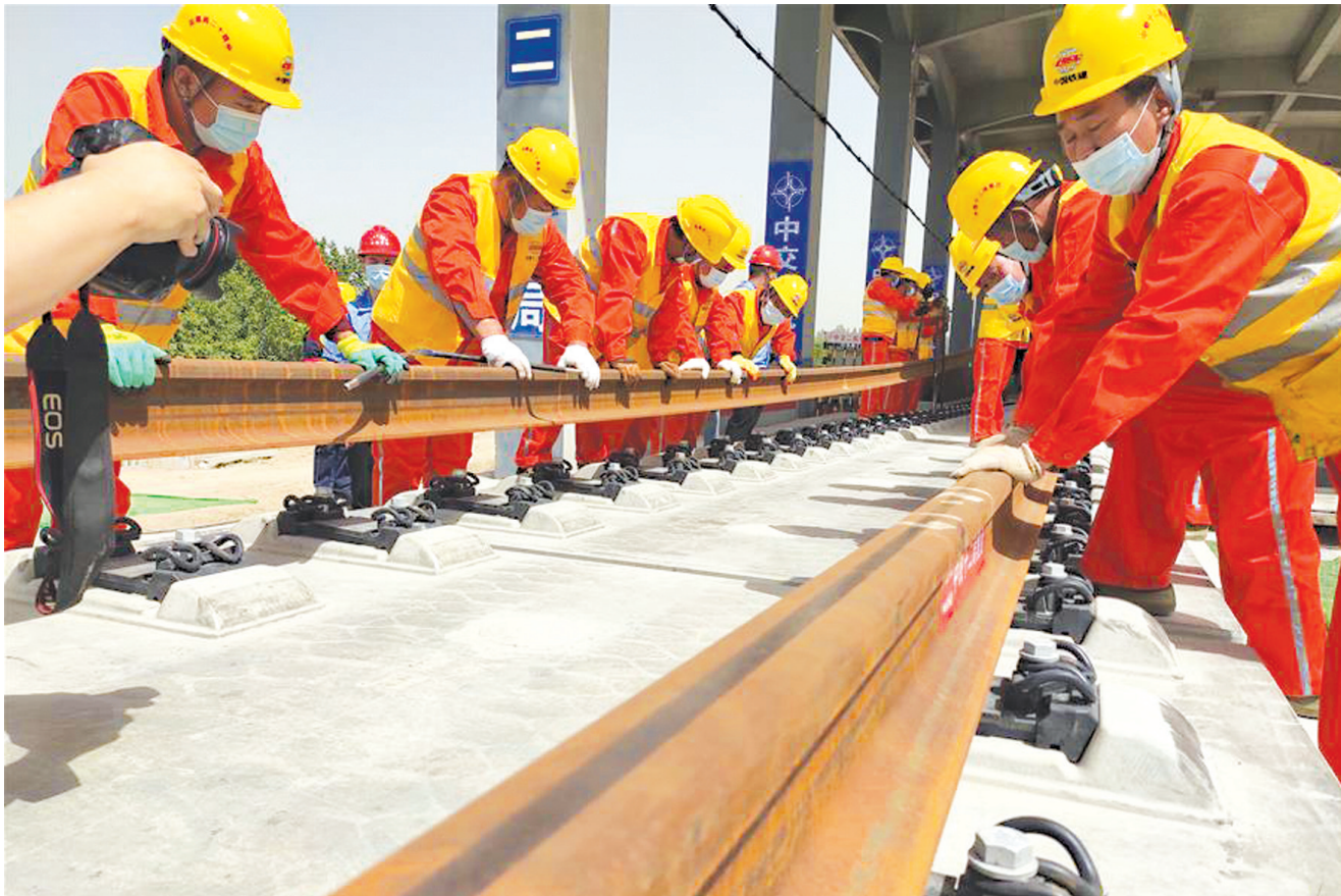
近日，北京至雄安城际铁路(河北段)开始铺轨，一组500米长钢轨平稳落在无砟道床上，标志着京雄城际铁路(河北段)建设进入铺轨阶段。
