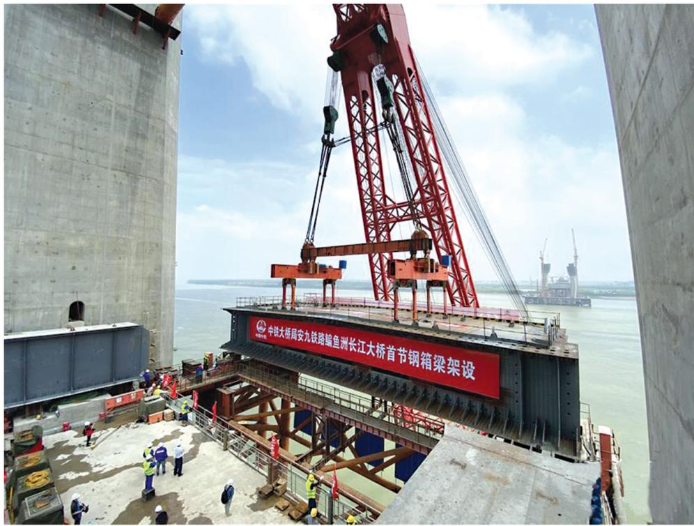
近日，随着重592吨的钢箱梁缓缓落在鳊鱼洲长江大桥南岸主塔横梁上，全国首座设计时速350公里的长江铁路桥完成首根钢箱梁架设。此后，这座大桥将进入上部结构施工阶段。图为鳊鱼洲长江大桥钢箱梁架设现场。新华社发
