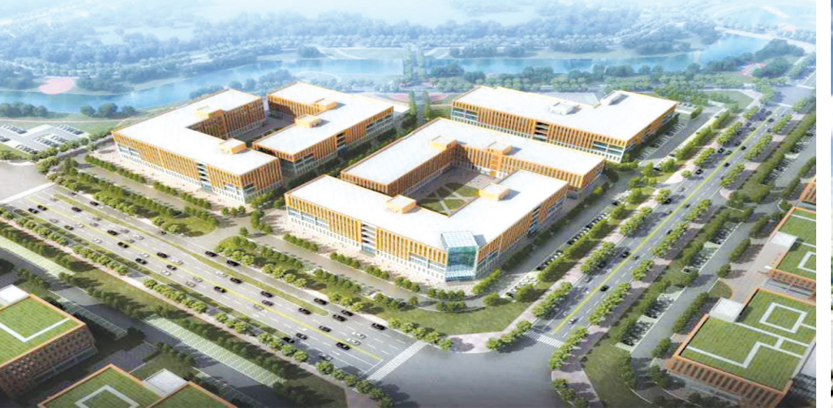
临沂高新区龙湾加速器
