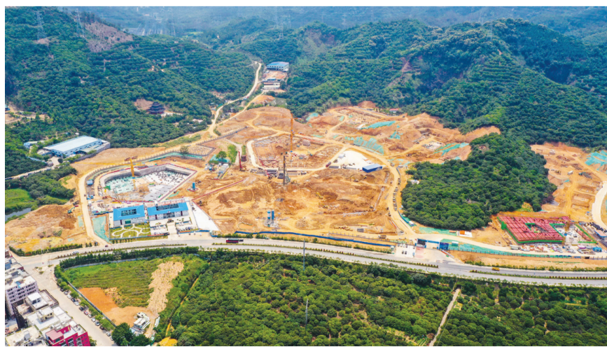
松山湖材料实验室一期工程(第一批)正在施工中
