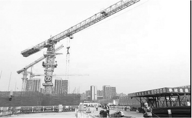
中关村昌平园小米智慧园区项目施工现场
