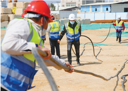
厦门火炬高新区中航锂电A6项目正式复工
