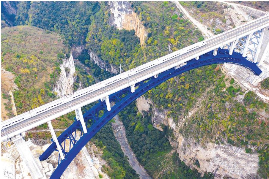
近日,成贵高铁进入全线拉通空载模拟运行阶段,试验列车在成都到贵阳区间内全线路运行。线路全长650公里的成贵高铁是我国“八纵八横”高速铁路网的重要组成部分,设计时速为250公里。图为试验列车驶过成贵高铁西溪河大桥。
