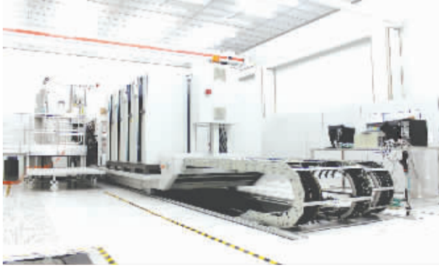
焦作嵩阳光电 ITO 导电膜真空磁镀膜生产线
