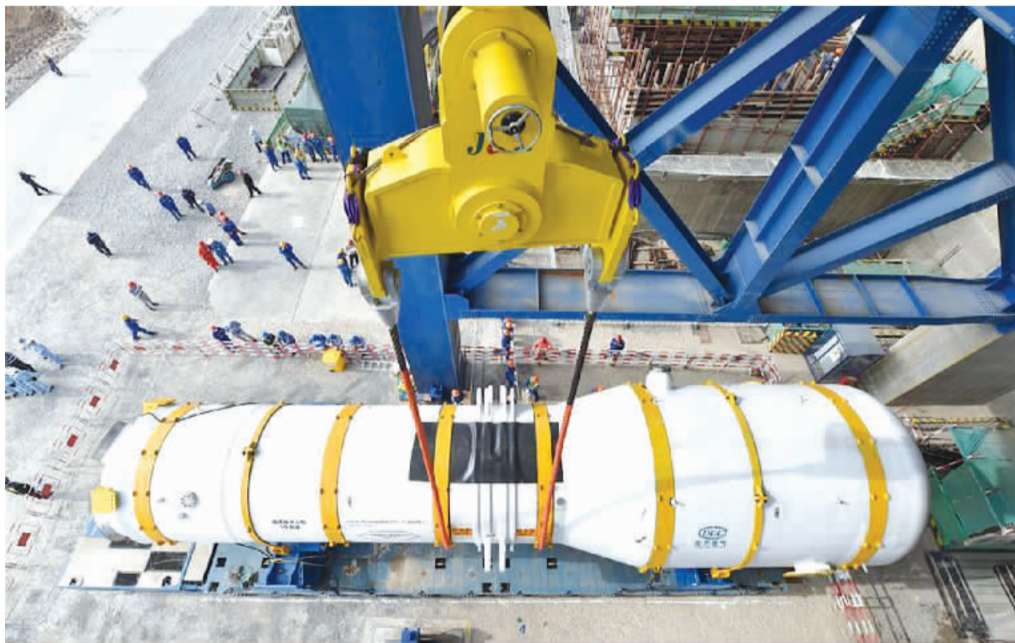
近日,“华龙一号”全球首堆示范工程——福清核电5号机组首台ZH-65型蒸汽发生器现场吊装工作准备就绪,这是“华龙一号”首台即将引入的主设备。据了解,作为我国三代核电自主品牌,具有自主知识产权的“华龙一号”核能发电机由东方电机自主研发,将应用于中核集团福清核电站5、6号机组。图为工作人员在施工现场进行吊装前准备。
